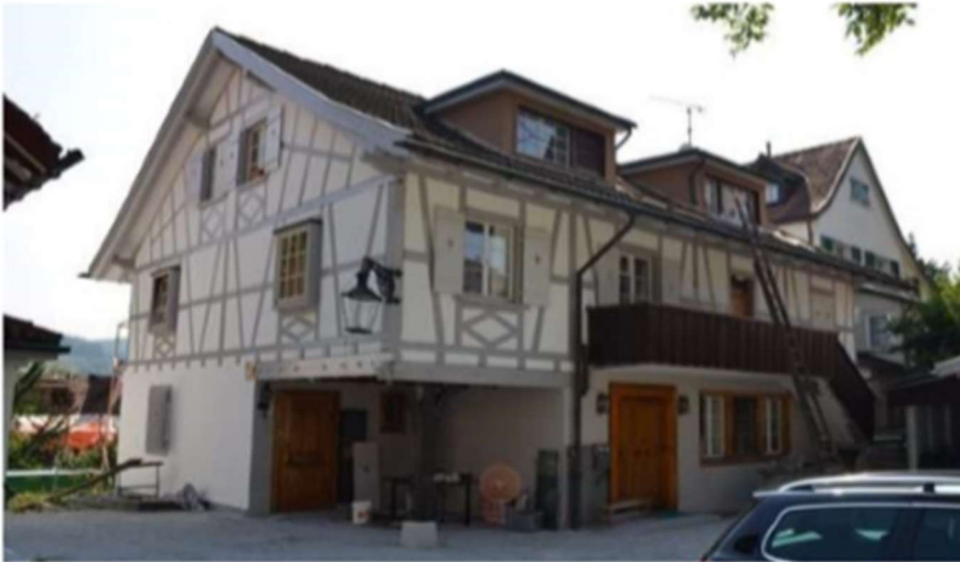
Heinestr. 1, 9000 St. Gallen
